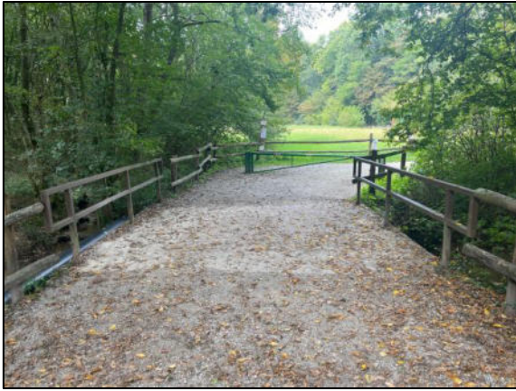
FOTO 1: INIZIO STRADA (PONTE)
